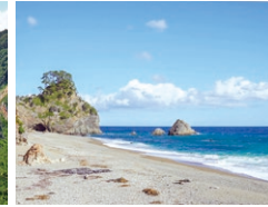
北山浜 断崖を貫く手掘りトンネルがある
